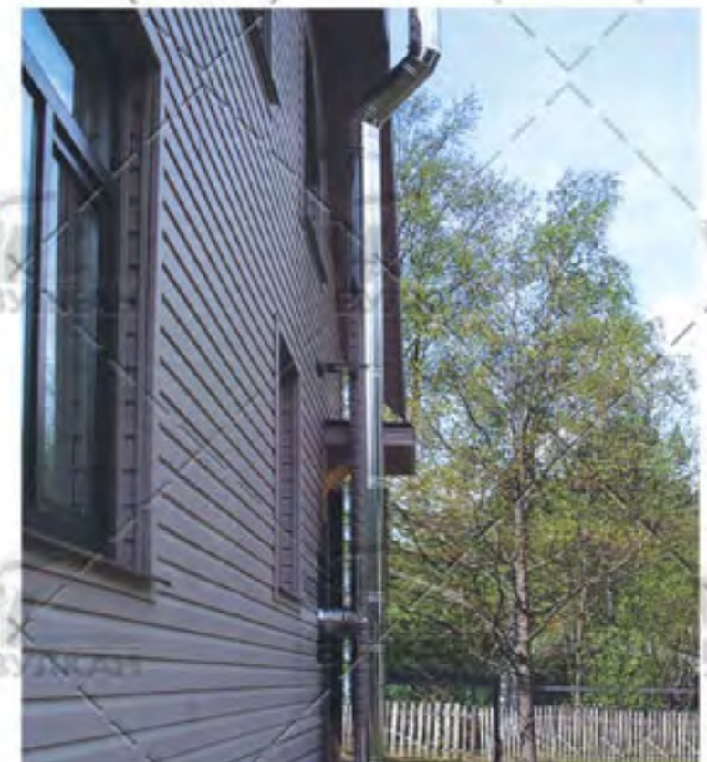
Частный дом. Зеленогорск трубы \varnothing 130/230
