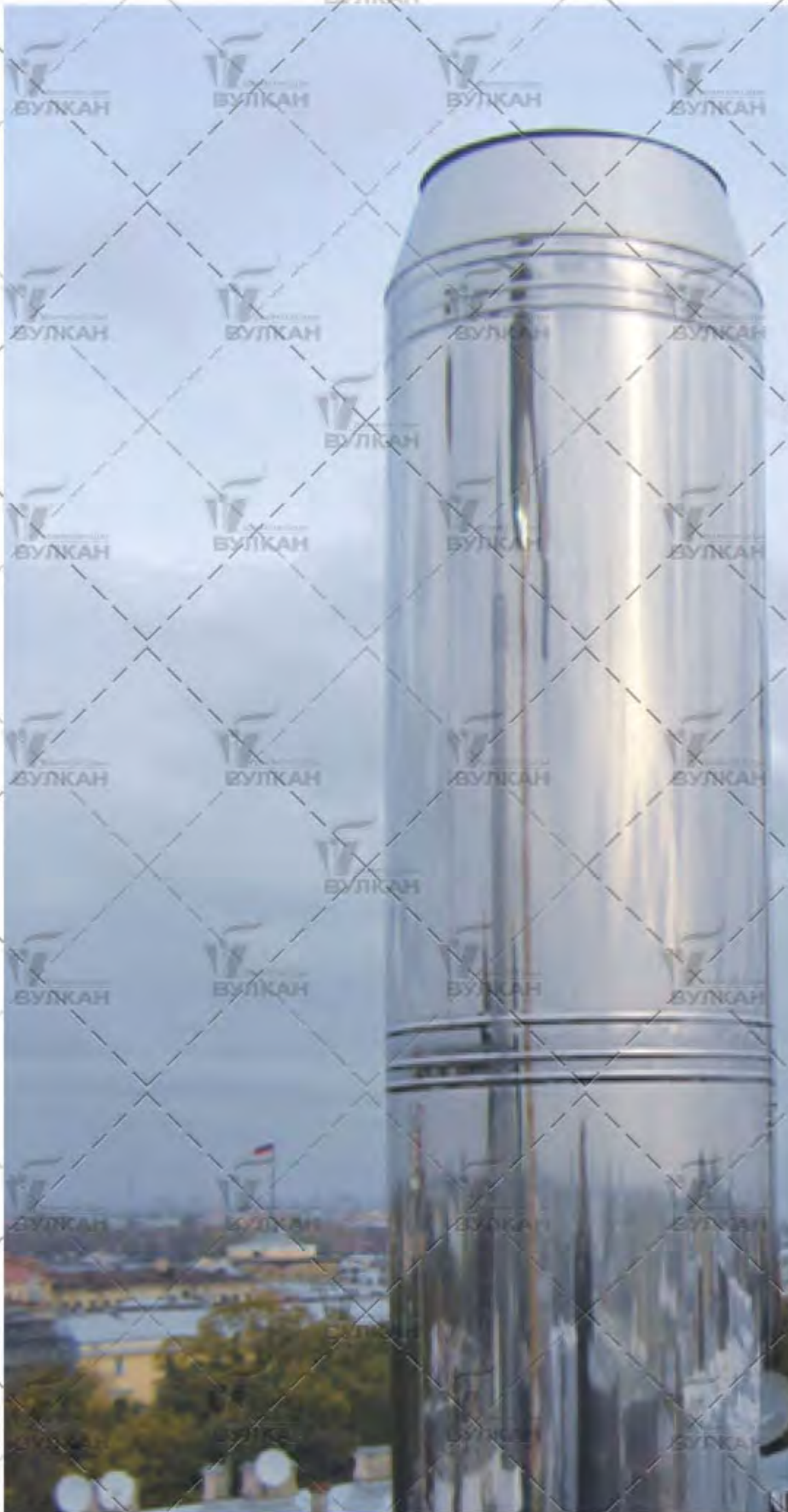
Арка Генерального штаба Два дымохода трубы \varnothing 500/600
