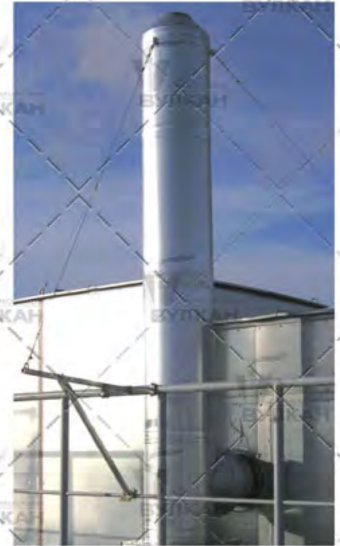
Завод по производству японских автомобилей NISSAN в пос. Каменка трубы \varnothing 100/200 \varnothing 200/300 \varnothing 250/350 \varnothing 300/400
